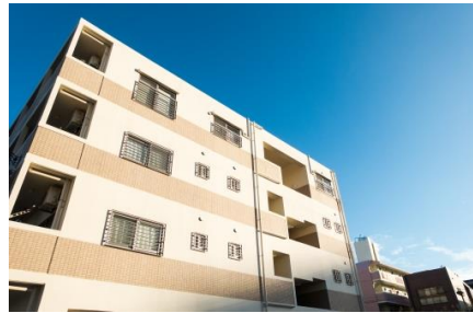
▲ 分譲マンション 共用部・駐輪場・駐車場・エレベータなどに設置
