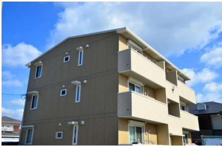
▲ アパート・コーポなどの賃貸物件 主に共用部に設置
