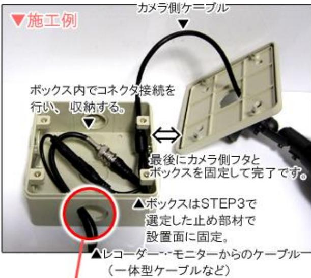
左写真のようにケーブルをボックス内に入れ込み、接続して写真の様にケーブルを収納してカメラ側のフタを被せてください。
