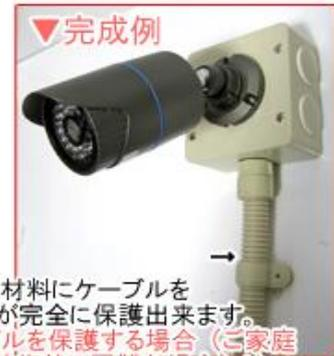
PF管という電気材料にケーブルを通すとケーブルが完全に保護出来ます。簡易的にケーブルを保護する場合（ご家庭やPF管設置が技術的に困難な場合）は踏まれないようなルートを確認してください。
