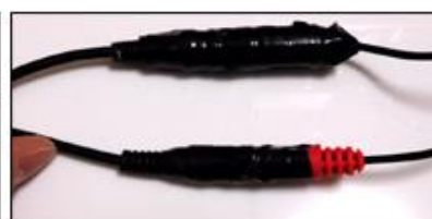
▲ 接続部をビニルテープで 嚴重に保護する ※文房具テープは不可 電気工事用をご利用ください。
