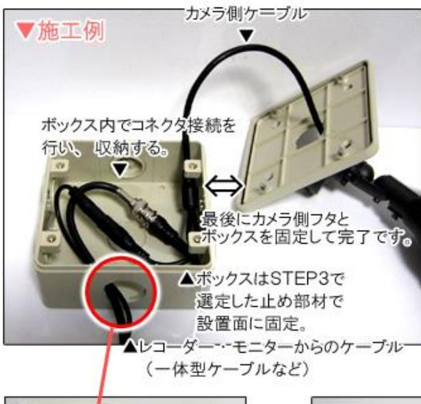
左写真のようにケーブルをボックス内に入れ込み、接続します。写真の様にケーブルを収納してカメラ側のフタを被せてください。
